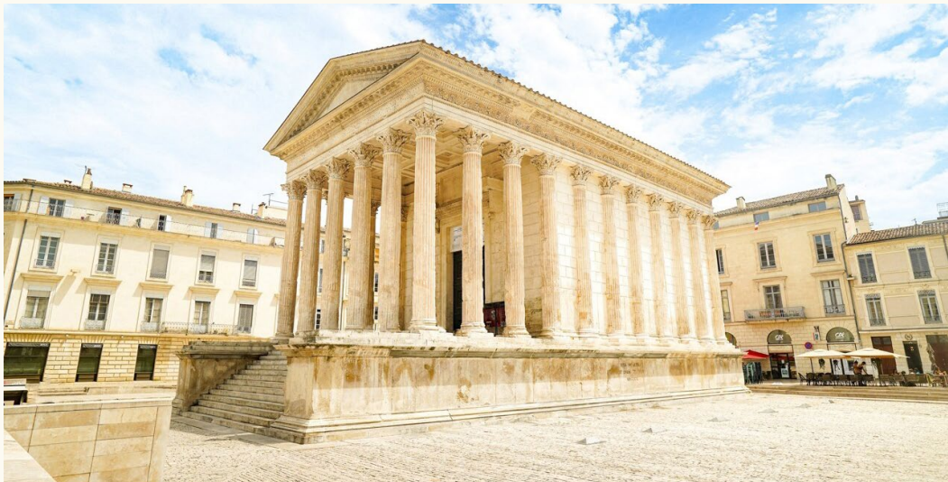
La Maison Carrée
