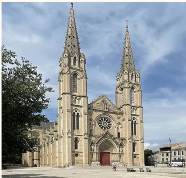
Église Saint-Baudile depuis la place des Carmes
